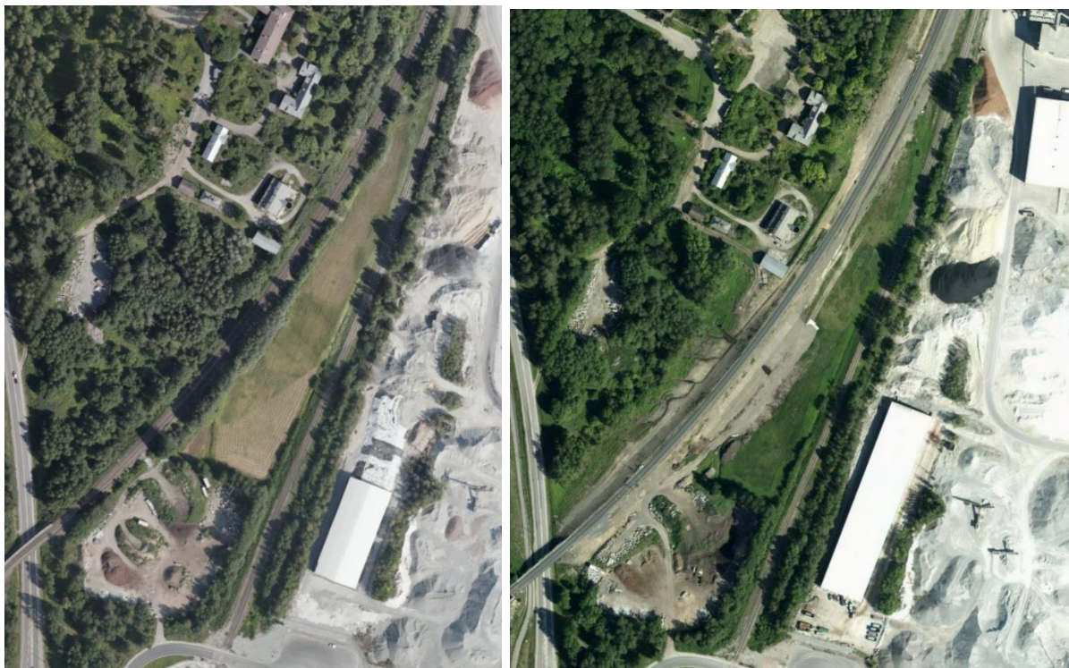
Kuva 4. Vasemmalla ortoilmakuva vuodelta 2018 ja oikealla ortoilmakuva vuodelta 2023. Radan ympäristössä on poistettu kasvillisuutta, ratapengertä on levennetty ja kuivatusojia on parannettu perusparannuksen yhteydessä. (© Field Group & Lappeenrannan kaupunki)
